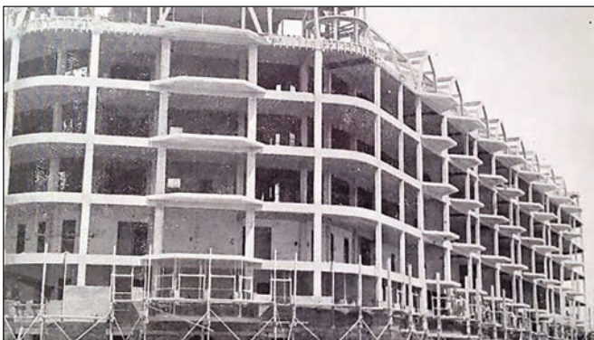
Finca Roja en construcción. 1929-33. Costó 19.000 pesetas
